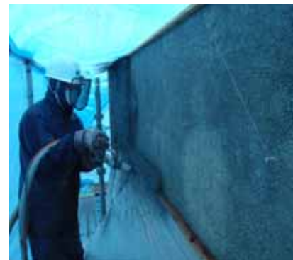
湿式吹付け施工
